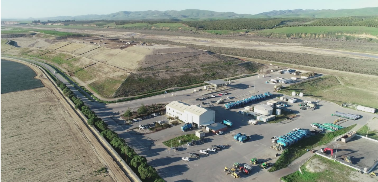
Santa Maria Landfill
